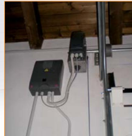
5) Applicazione con motore laterale
